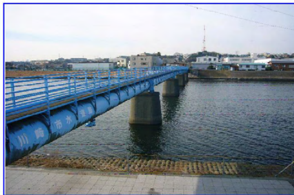
鶴見川水管橋
