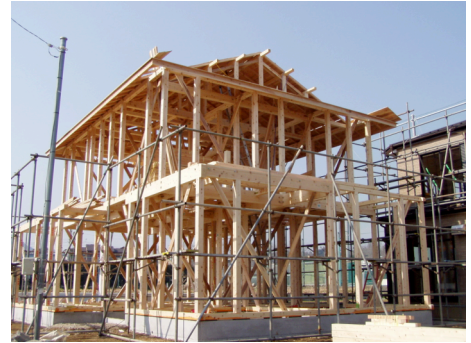
県産木材住宅の建築現場
